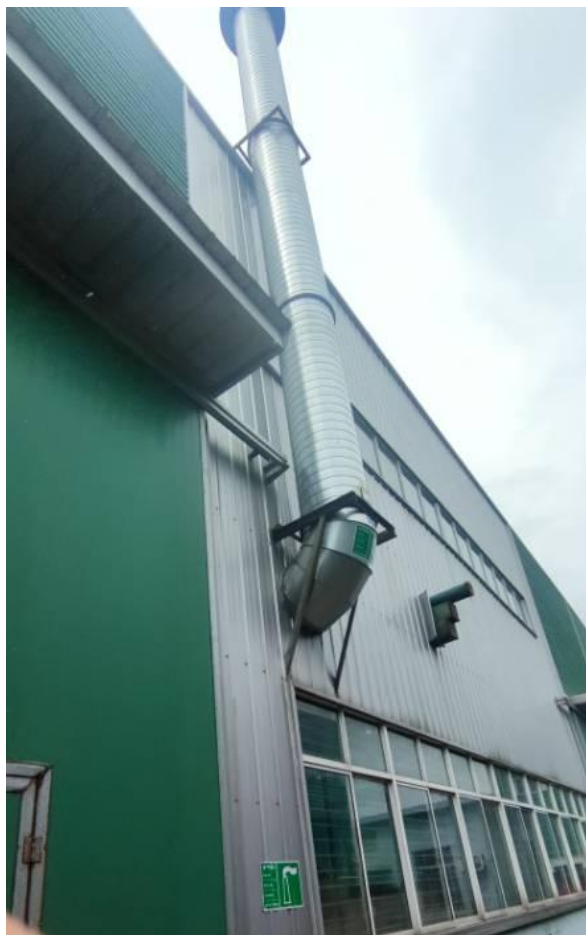
浸漆烘干废气标识牌及排气筒
